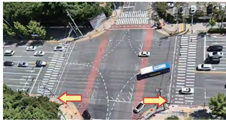
대구 동본리네거리 교차로 횡단보도 이격 설치 모습(사거리 중심에서 멀어지게 설치)
