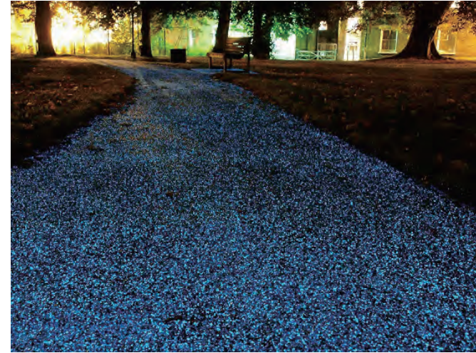
산책로에 설치된 스타패스 ©Pro-Teq Surfacing
