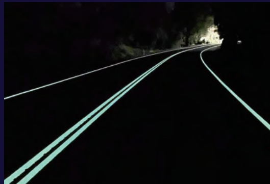
호주에 설치된 야광 도로 낮(위)과 밤 ©Tarmac Linemarking
