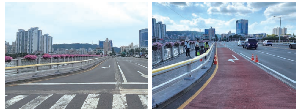
진주시 희망교사거리 횡방향 그루빙 설치 전(좌)·후(우) 현장 사진
